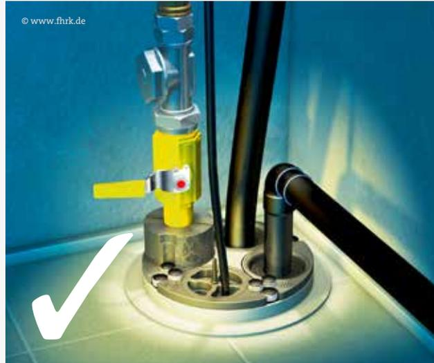
Abb. 1: Beispiel Mehrspartenhauseinführung (theoretisch)
